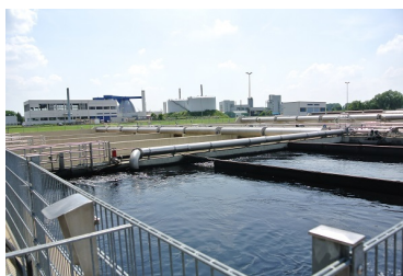
4. Reinigungsstufe auf der Kläranlage Mannheim.
